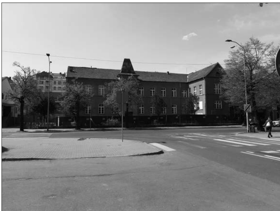
Budynek dawnego szpitala PCK przy ul. Kosynierów Gdyńskich, 2022 (fot. autor)
